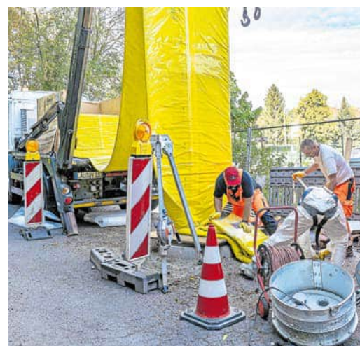
Mit der Schlauchlining-Technik – hier in der Arndtstraße – werden zeit- und kostensparend Kanäle saniert.
