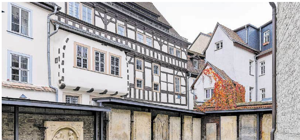
Die Auskragung an der Gebäudefassade zeigt: Hier gibt es eine Bohlenstube.
