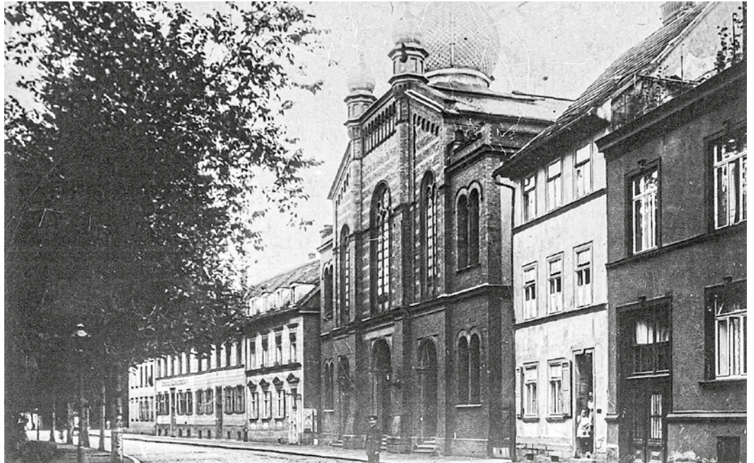
Die Große Synagoge Erfurt war vor ihrer Zerstörung 1938 ein imposantes Gebäude. © Stadtarchiv Erfurt
