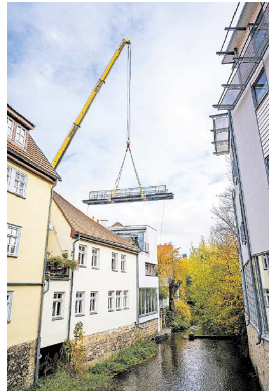
Am Kran schwebte das Bauwerk über die Dächer der Altstadt. © Steve Bauerschmidt
