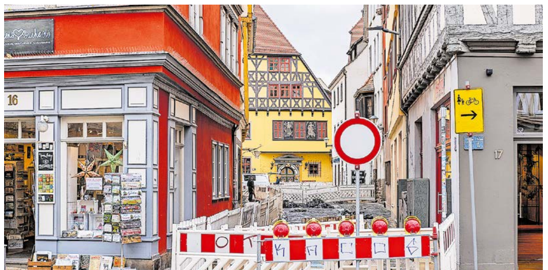
Voraussichtlich bis zum Frühjahr 2024 wird in der Großen Arche gebaut.
