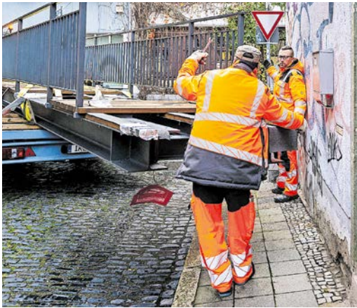
Millimeterarbeit in der Nonnengasse: Ein Traktor transportierte die Brücke. © Steve Bauerschmidt
