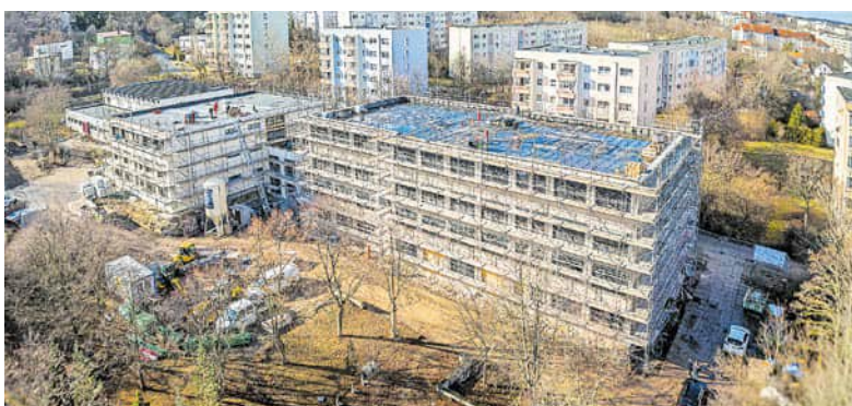
Fast 20 Jahre lang stand der Gebäudekomplex in der Albert-Einstein-Straße 37 leer. Bald soll er wieder als Schule genutzt werden.
