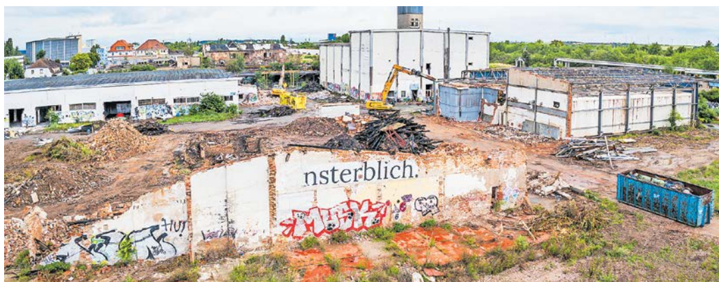
Die Bagger tragen die Bestandsgebäude Stück für Stück ab.
