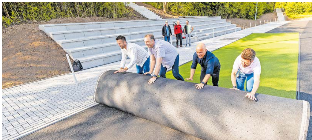
Von links: René Hofmann, Sportbeauftragter, Jens Batschkus, Leiter des Erfurter Sportbetriebs, Andreas Horn, Oberbürgermeister, und Kai Martin, Abteilungsleiter Technisches Sportanlagenmanagement im Erfurter Sportbetrieb, rollen die erste Bahn Kunstrasen aus.
