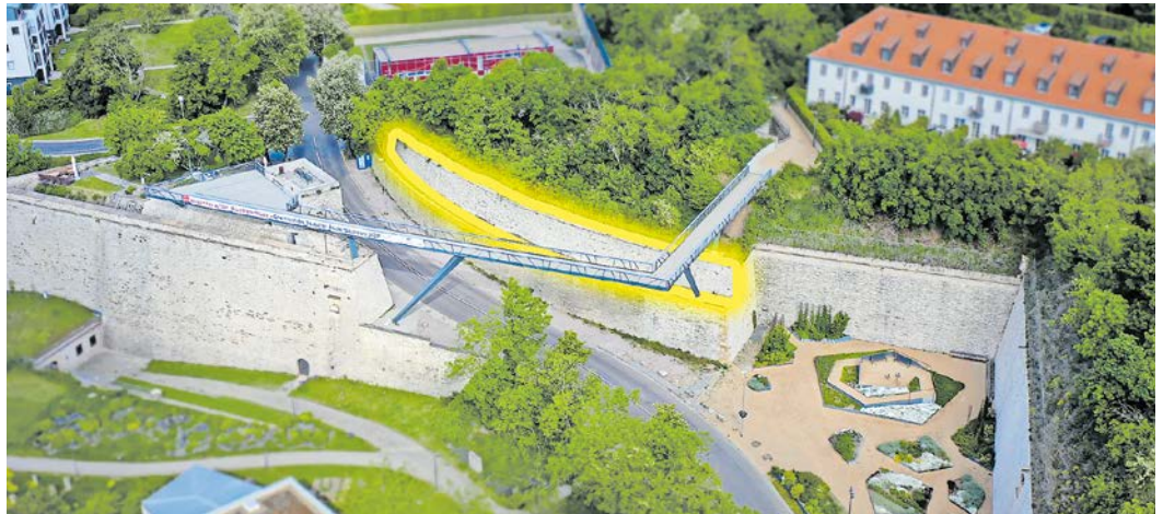
Die obere Stützwand der Bastion Gabriel wurde statisch ertüchtigt und instand gesetzt.
