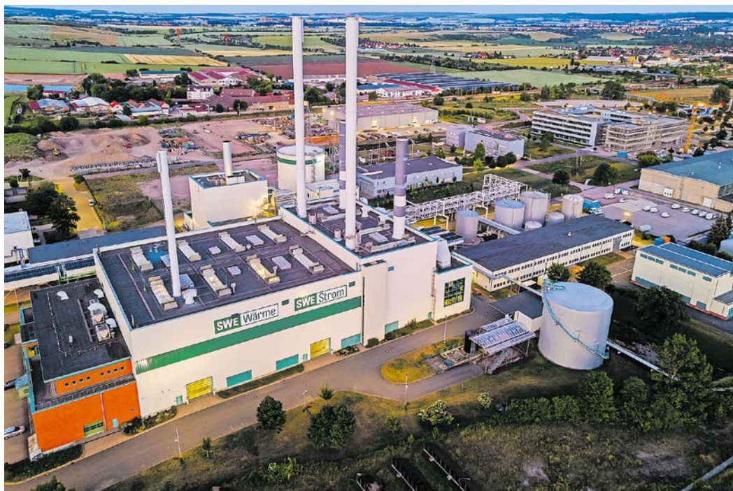
In der Gas- und Dampfturbinenanlage der SWE Energie GmbH wird durch Kraft-Wärme-Kopplung (KWK) gleichzeitig Strom und Wärme erzeugt. Die so gewonnene Wärme gelangt über das Erfurter Fernwärmenetz zu 48.000 Haushalten, Unternehmen und Industriebetrieben. © Andreas Hultsch
