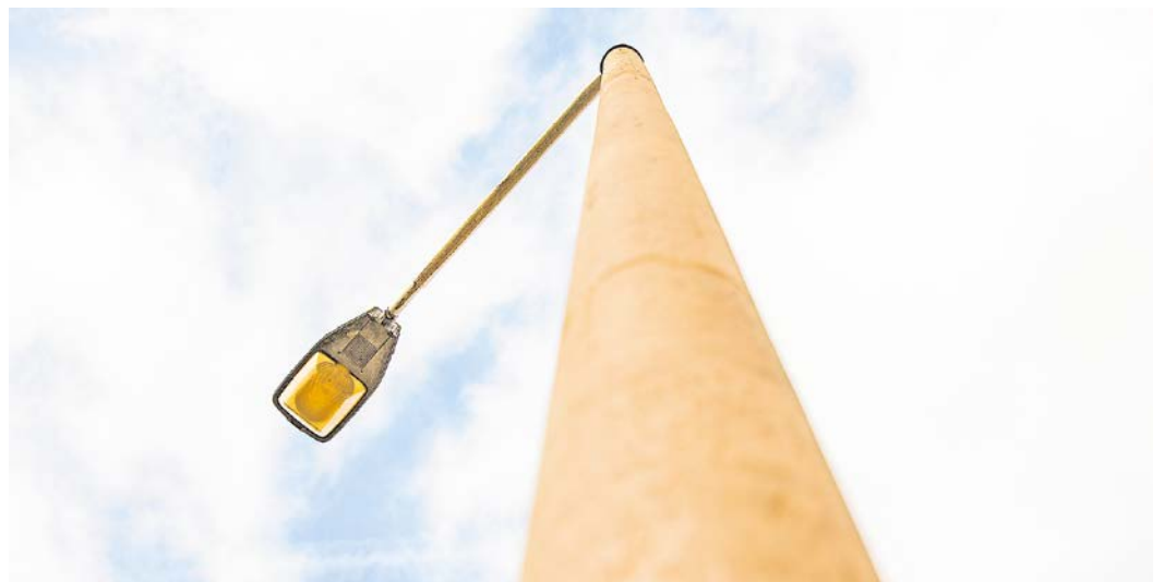
In der Thälmann- und der Liebknechtstraße werden die alten Betonmasten ausgetauscht.
