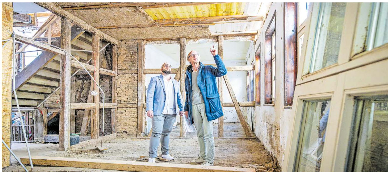
Arne Ott, Leiter des Amtes für Gebäudemanagement (links), und Architekt Franz Bruns besichtigten die Baustelle.
