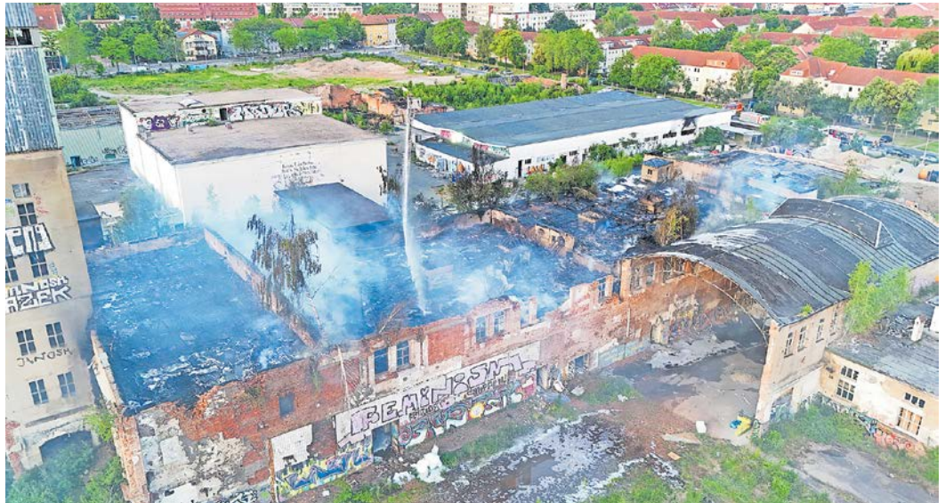
Das ehemalige Kühlhaus direkt neben der Bogenhalle ist völlig ausgebrannt.
