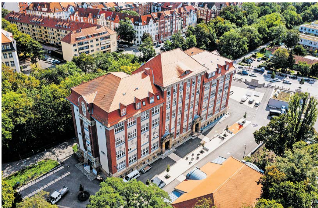
Die Sanierung der Jenaplanschule am Nordpark wurde 2023 abgeschlossen. © Steve Bauerschmidt
