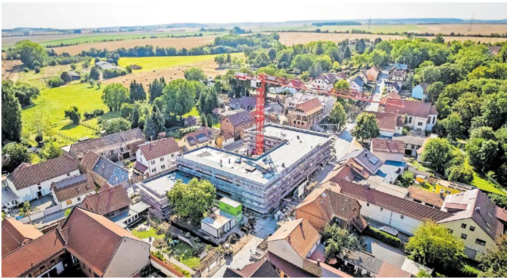
Voraussichtlich Ende 2026 soll der Ersatzneubau in der Straße der Jugend in Betrieb gehen.
