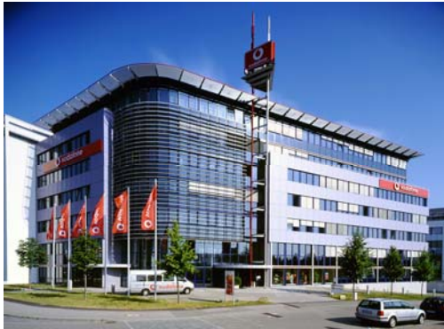
GOBAPLAN Büro- & Verwaltungsgebäude
