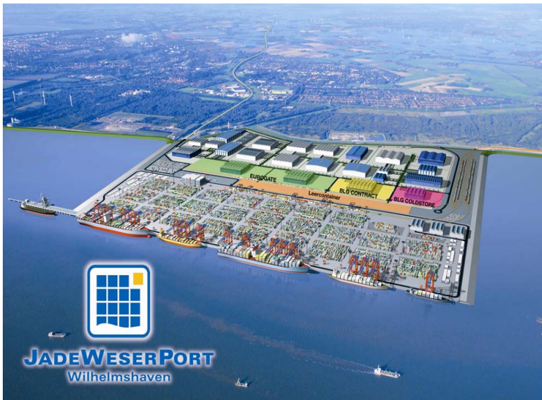
Hafenbau- und Erweiterung
